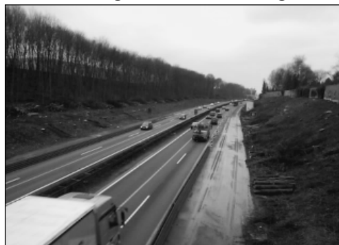
Eine Schneise durchzieht Wattenscheid: Ausbau der A 40
